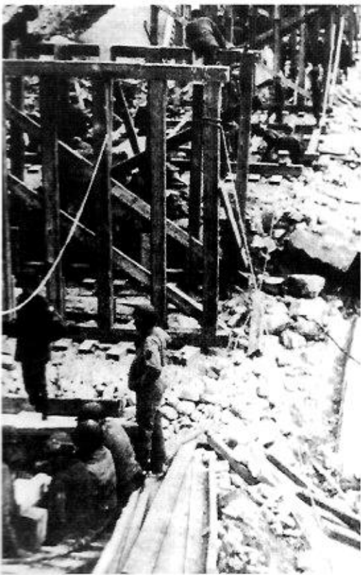
Construction d'un pont provisoire.
