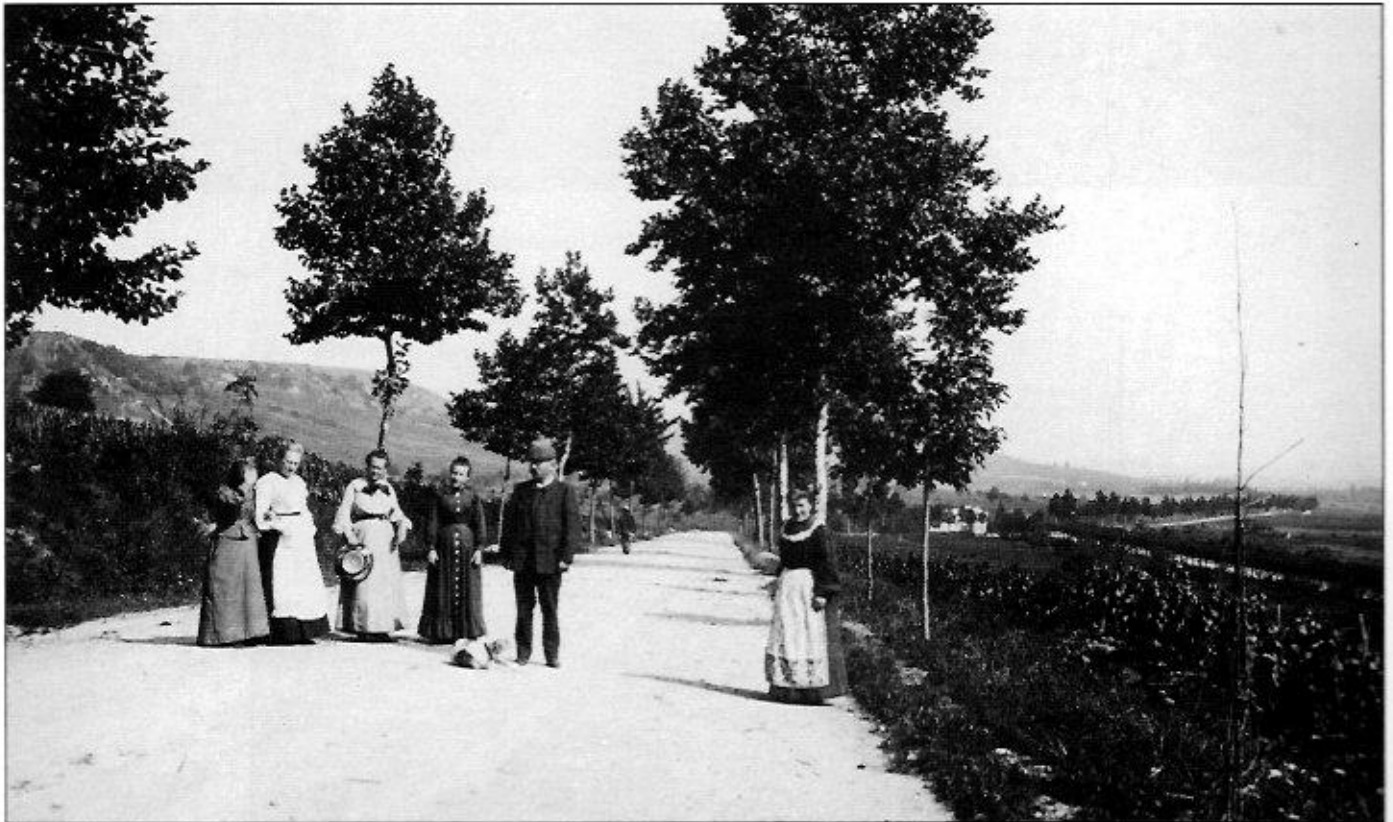
La route nationale N°4 (ancienne route royale n°4)
