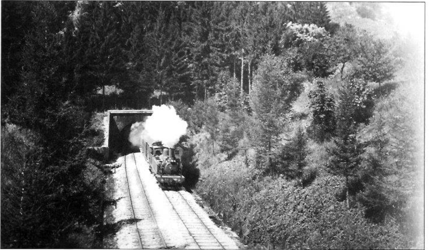
Convoi ferroviaire sortant du tunnel.
