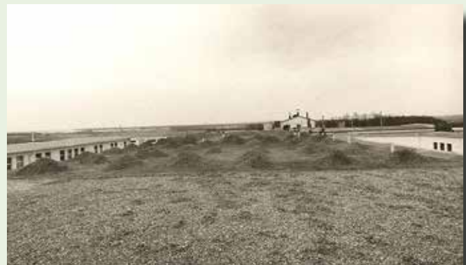
Figure 12 : une vue du chantier de rénovation des toitures après le transfert de l'hôpital au CHR. Photographie offerte à l'auteur par le CHR en 2007.
