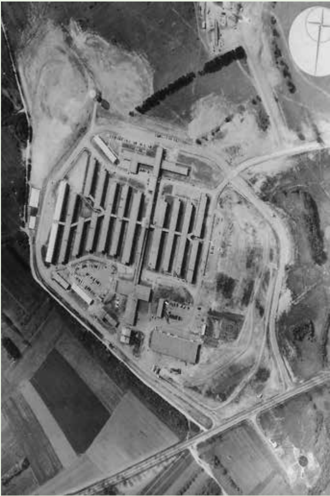
Figure 1 : photographie aérienne de l'hôpital Jeanne d'Arc et de son chantier. L'entrée de l'hôpital, éloignée de la route, est en haut de la photographie. On distingue en haut et à droite la zone d'exercice où un pont est en cours de montage, et, en bas et à droite, la route nationale et la station d'épuration. La photographie, non datée, a sans doute été prise au début de la décennie 1960 car tous les bâtiments sont présents. Elle a été offerte à l'auteur par le CHR.
