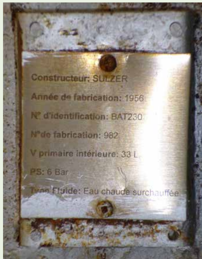
Figure 7 : plaque posée en 1956 portée par un dispositif de chauffage. Photographie de l'auteur prise en 2017 à l'occasion d'une visite officielle précédant le démantèlement des locaux.
