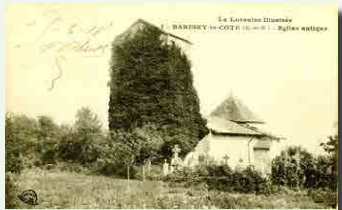
Barisey-la-Côte, 5 mars 1918, l'église fortifiée, construite entre la fin du XII e et le début du XIII e siècle, s'est isolée dans les vignes. On comprend, à voir cette carte postale, le sens de l'expression locale « Aller reposer sous le lierre ».
