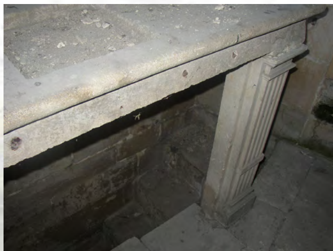
Cathédrale de Toul, départ de l'escalier d'accès au caveau de la chapelle du « Jeudi Saint », dissimulé sous l'autel de la salle haute, cl. V. Lamarque, 26 juillet 2007.
