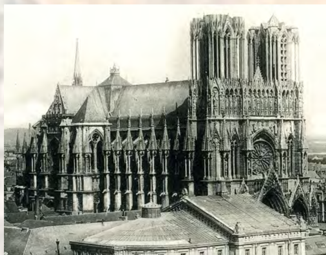
La cathédrale de Reims, dans son état antérieur à la Grande Guerre, avec ses combles reconstruits après l'incendie de 1481 et le socle de la flèche prévue au début du XVIe siècle sur la croisée, photo. d'époque, d'ap. A. Villes.
