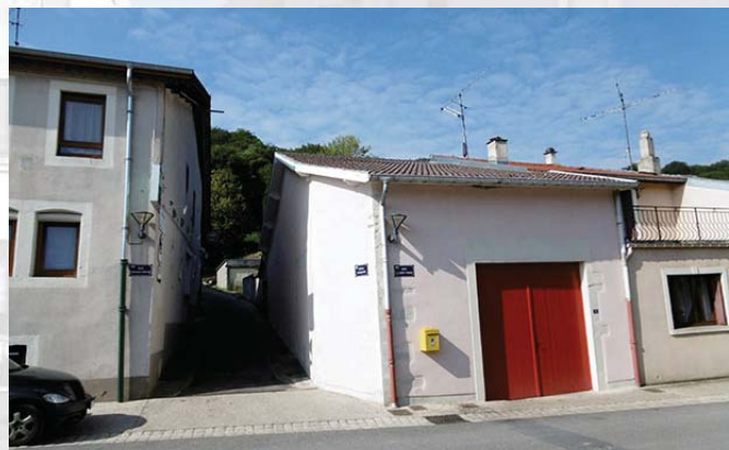
L'édifice qui fait l'angle, avec la boîte aux lettres jaune est à l'emplacement du pressoir communal refait en 1833
