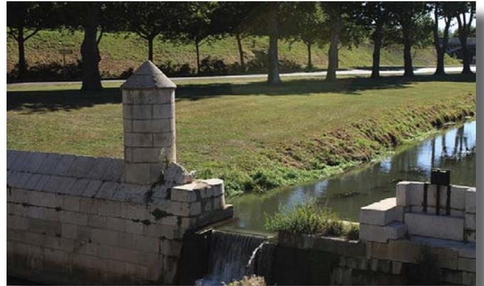
*Demoiselle sur son batardeau, trop-plein et vanne permettant l'écoulement des eaux des fossés dans le canal Vauban*
