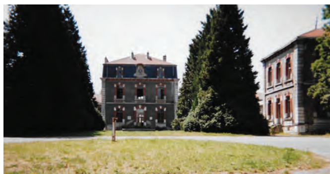
Fig. 5 : le bâtiment administratif.
