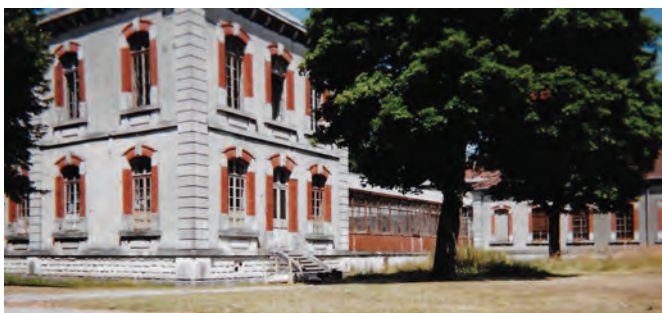
Fig. 4 : un pavillon d'hospitalisation et sa galerie de liaison.
