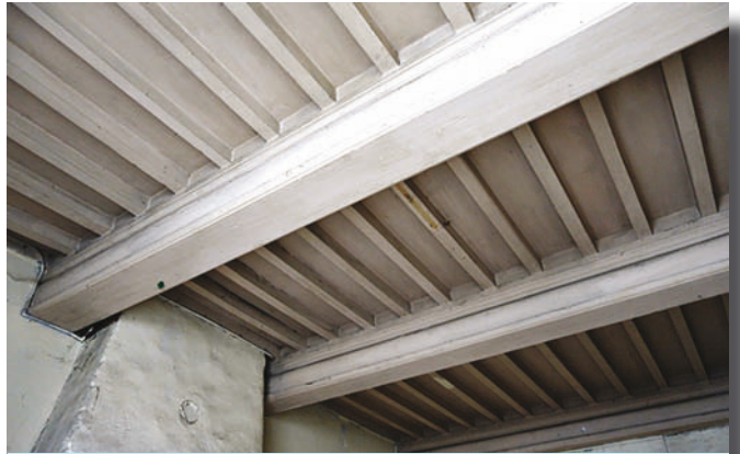
Détail d'un plafond et d'une cheminée.
