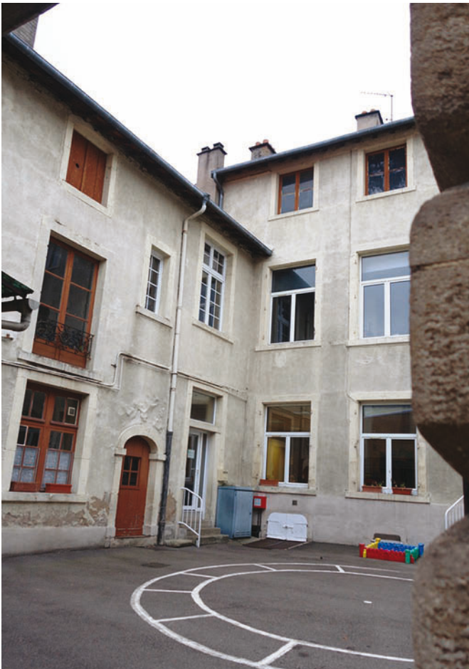
Immeuble en U : côté est.
