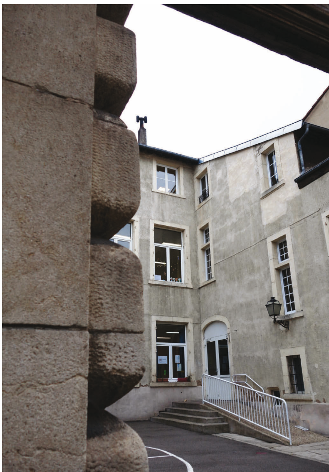
Vue sur l'immeuble en U, côté ouest.
