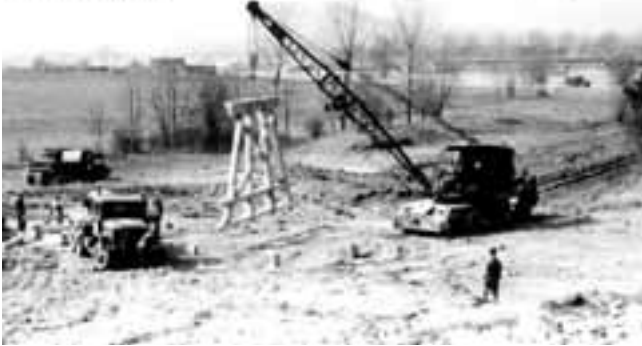
3. Mise en place d'un pilier en bois à Toul, très vraisemblablement dans l'enceinte du quartier et de l'hôpital.
