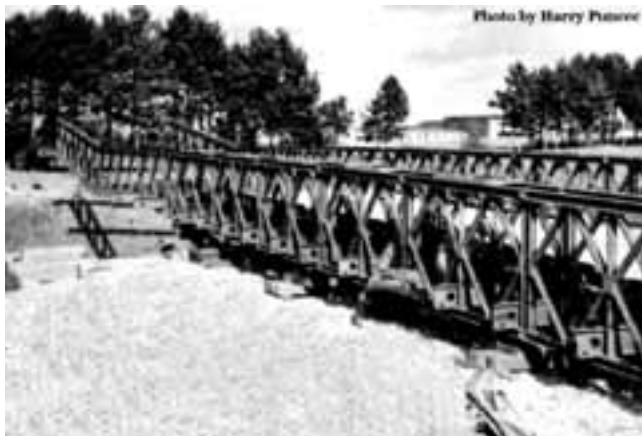
5. Pont Bailey reposant au sol. Au fond à droite, entre les arbres, vraisemblablement les bâtiments administratifs de l'hôpital Jeanne d'Arc .
