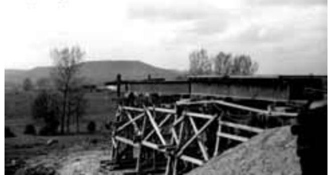
4. Début de réalisation d'un pont Bailey avec mise en place de piliers en bois. Au fond les collines de Toul.
