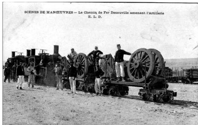
Pièces de siège sur équipement roulant formé de deux trucks reliés par barres d'accouplement. Collection Particulière
