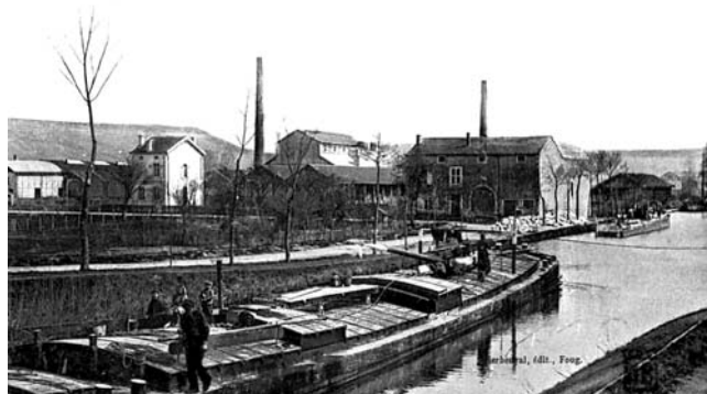
Foug. - Usine du Carrelage (Prise du Canal).
