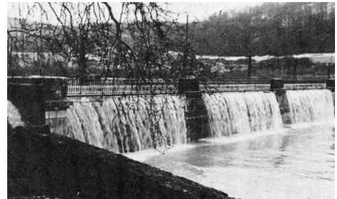
Les eaux passent par-dessus le pont-canal
