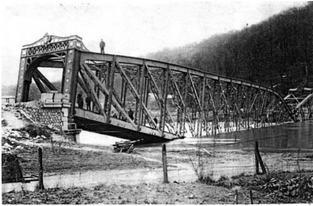
Les monteurs de la chaudronnerie découpent le pont de Liverdun (Cliché Ernest Geindre, 1944)
