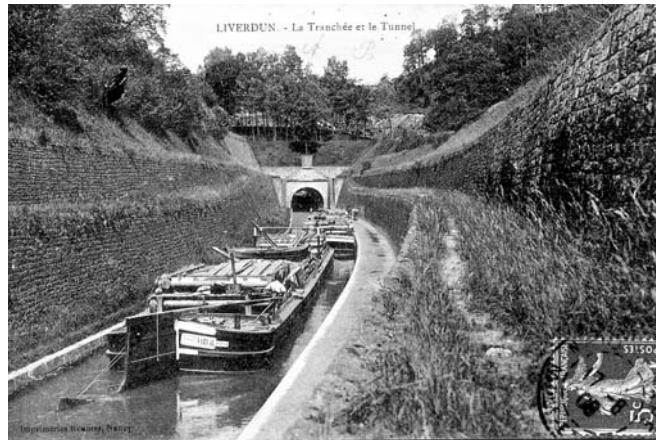
Liverdun : la tranchée et le tunnel (Carte postale ancienne)
