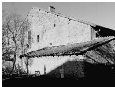
Façade Est avec bretèche et fenêtres à barreaux ou comblées (novembre 1999)
