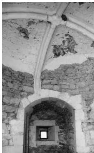
Tour sud, niche de tir
