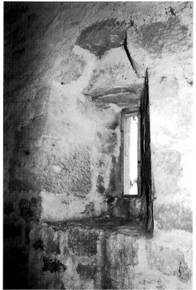
Archère percée dans le mur nord du premier étage de la tour
