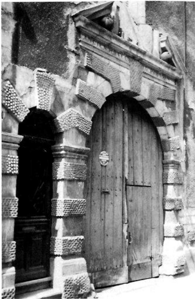
N°8 - Rue Gengoult
