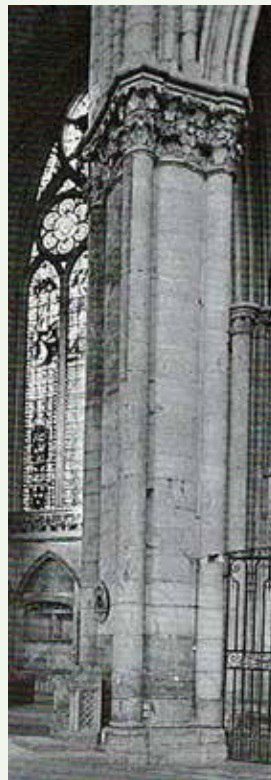
7. Pile de type « rémois », dans l'angle nord-est de la croisée de la cathédrale de Toul (photo. A. Villes).
