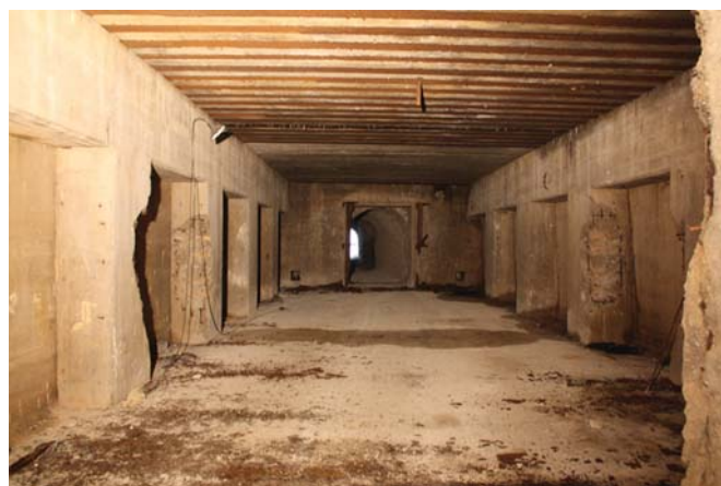
Ancienne usine allemande.
