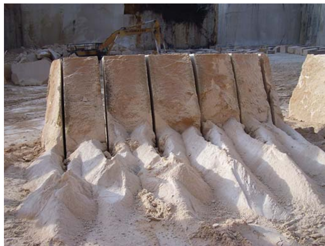
Sciage au sol d'une garde avec la haveuse sur chargeur.
