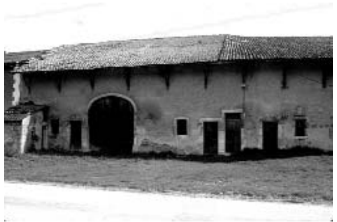
Traveron (Meuse), remarquable façade des XV e -XVII e ( ? ) siècles, que Joseph Simonin ne pouvait manquer d'admirer quand il passait par ce petit village.
