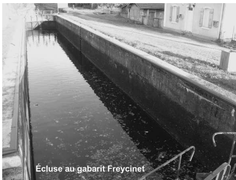
Écluse de Messein
