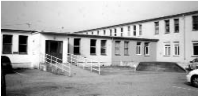
Aspect général actuel : l'entrée est à droite, dans le pavillon à étage. Photo P. Labrude.
