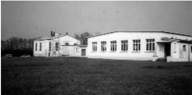
Chaufferie et service de restauration.
