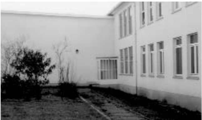
“Coin” de couloir et de bâtiment avec sas d'origine. Photo P. Labrude.
