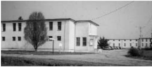
Aspect général actuel des bâtiments.
