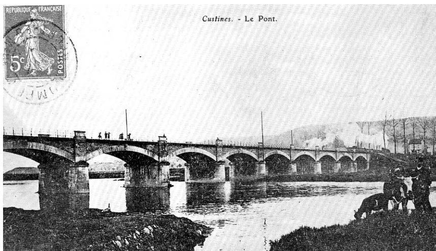
Le pont de 1882
