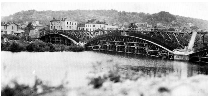
Les cintres pour la construction des arches
