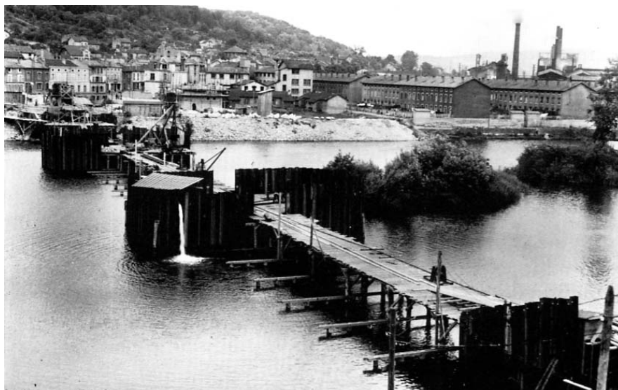
Débuts de la construction de pont de 1950
