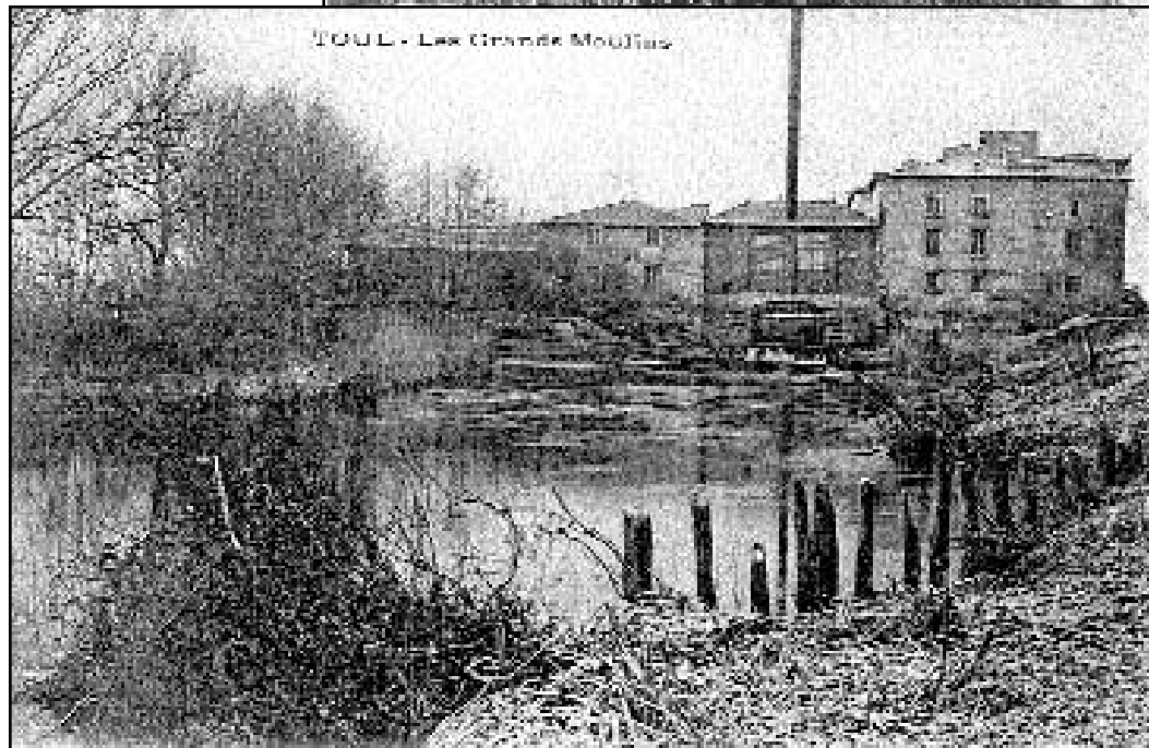
1909 Installation d'une machine à vapeur entre le petit et le grand moulin
